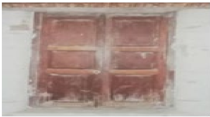
Rajah 2. Pengelupasan cat pada pintu
