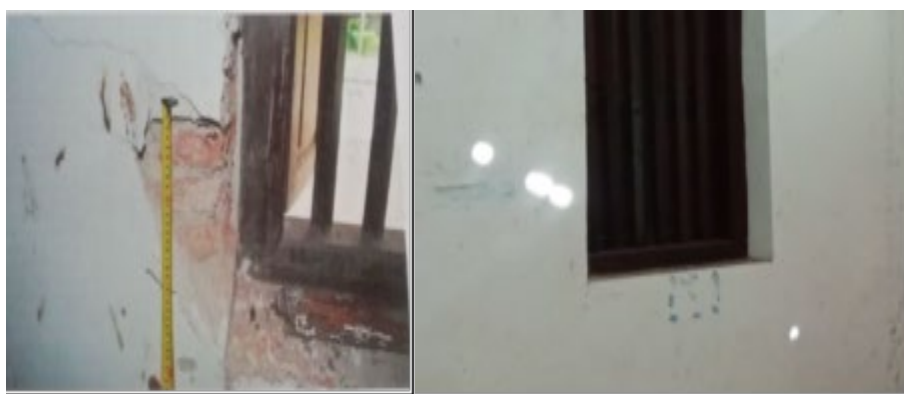
Rajah 4. Lepaan dinding yang pecah dan retak (kiri) dan keadaan dinding selepas dibaikpulih (kanan)
