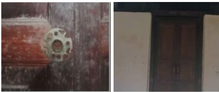
Rajah 3. Tombol pintu yang telah tertanggal (kiri) dan pemegang pintu yang baharu (kanan)
