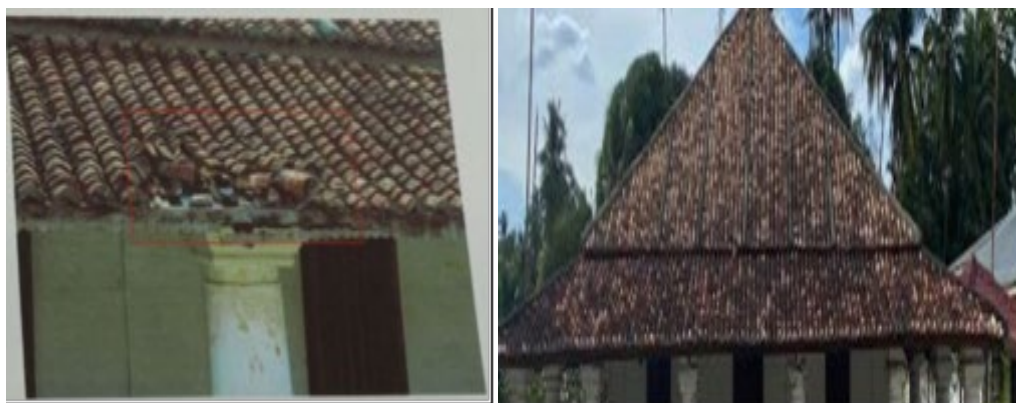
Rajah 5. Jubin yang pecah, tertanggal dan berlumut (kiri) dan bumbung masjid setelah dicuci (kanan)
