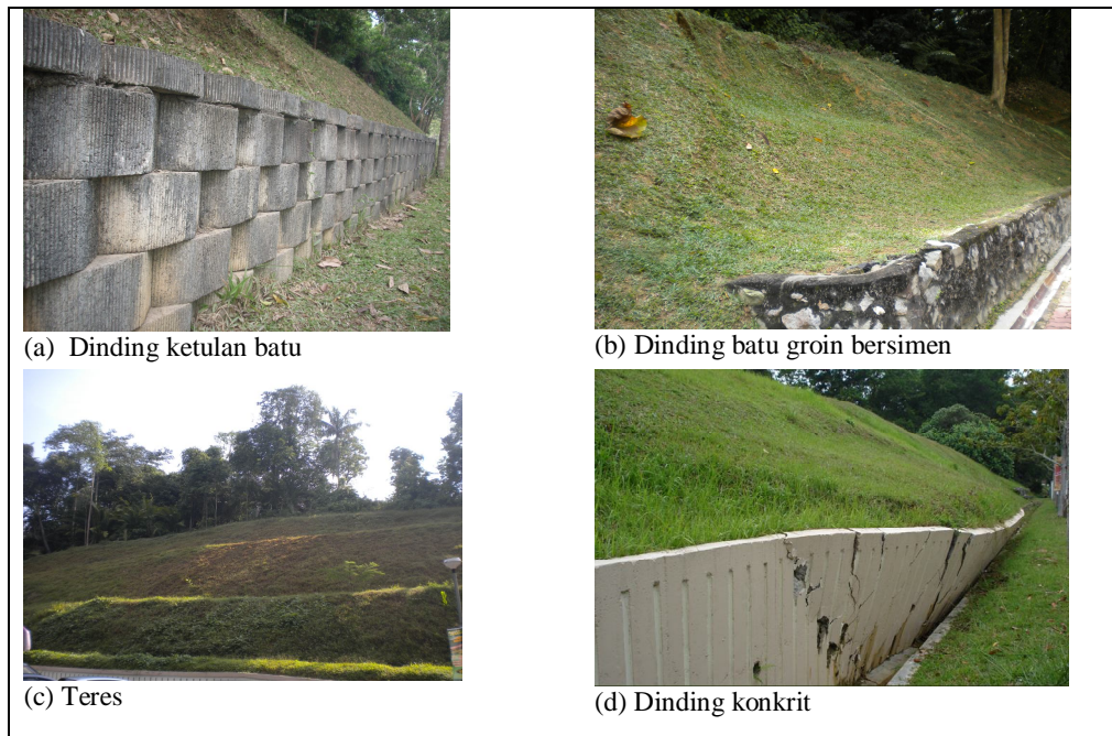
Foto 2. Kaedah mitigasi yang digunakan di cerun bermasalah di kampus UKM, Bangi
