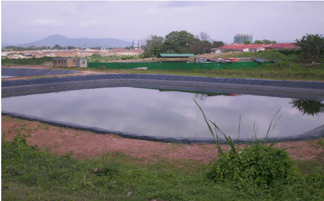
Foto 4. Kolam yang digunakan untuk menampung air lelehan di kawasan tapak pelupusan
