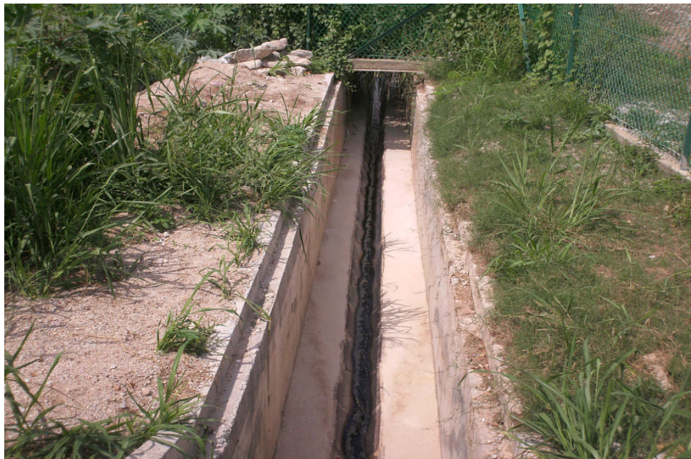
Foto 1. Longkang yang digunakan untuk mengalirkan air lelehan ke dalam kolam takungan
